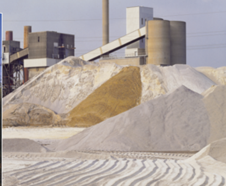
Die Schachtofenanlage (links) hat 3000 t Tageskapazität.
