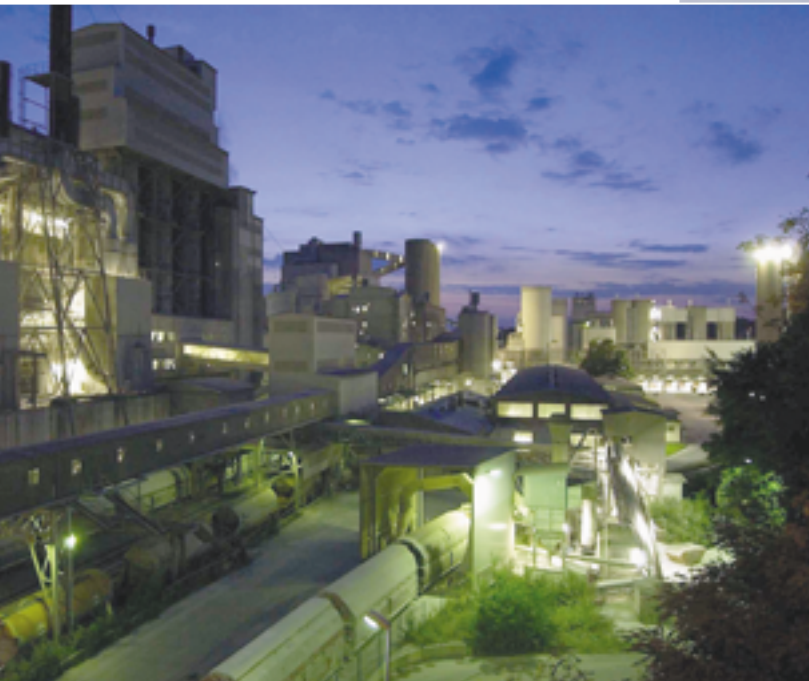
Die Schachtofenanlage (links) hat 3000 t Tageskapazität.
