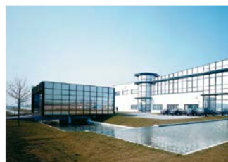
ODS Optical Service GmbH 264 caméras MOBOTIX, Allemagne
