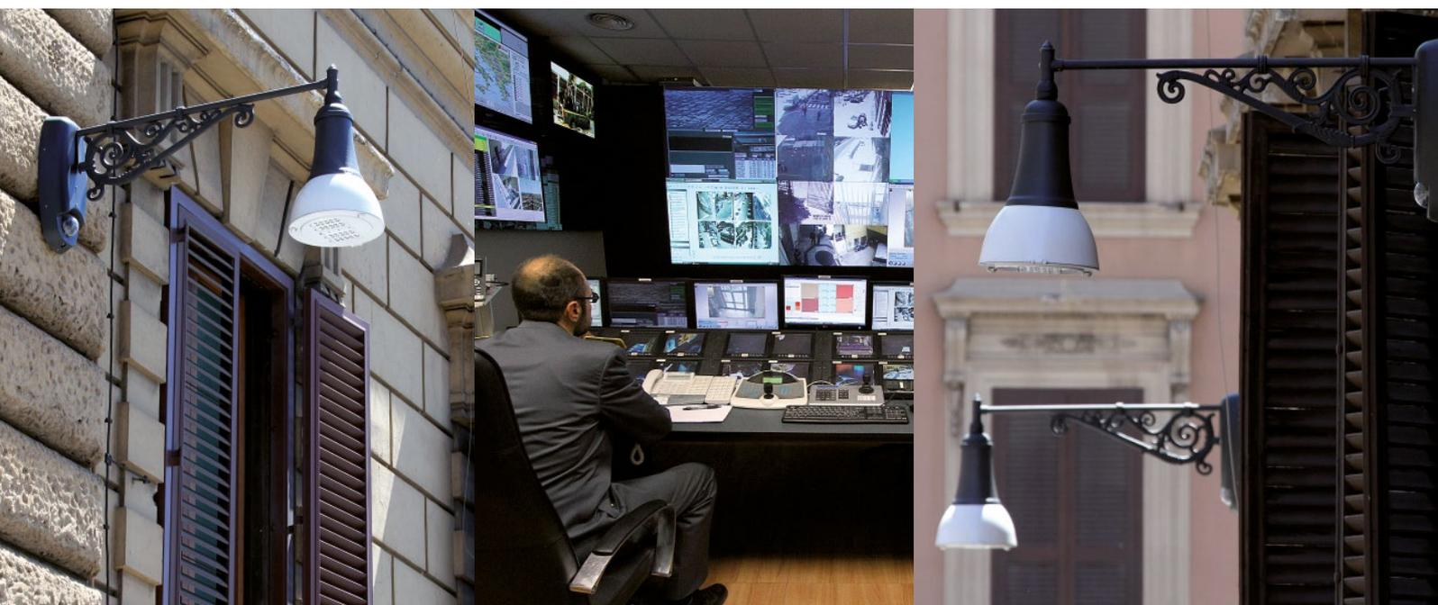
il passaggio di un pedone o il rilevamento di un suono. Le telecamere posizionate in prossimità degli accessi al Ministero sono in grado di inviare allarmi in tempo reale all'interno della centrale operativa o di gestire i sistemi di apertura e di chiusura dei dissuasori antisfondamento nel terreno grazie a un sistema di letture delle targhe delle autovetture.
