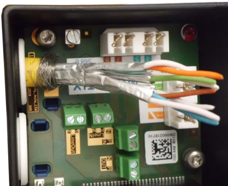
Fig. 60: Câble réseau inséré, bouchon correctement installé
