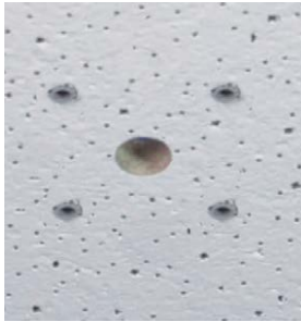
Abb. 14: Löcher bereit für Montage
