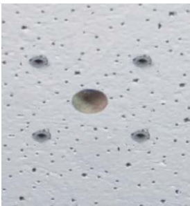
Abb. 16: Löcher bereit für Montage
