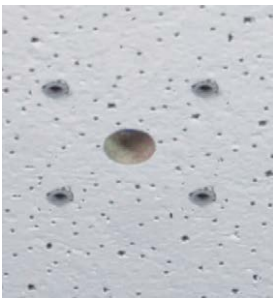
Fig. 16: Trous prêts pour le montage
