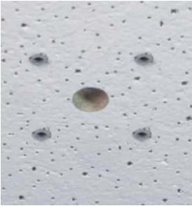
Fig. 14: Trous prêts pour le montage
