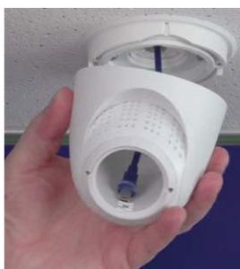
6. Use los dos tornillos para fijar el conjunto de pie y esfera en la anilla giratoria y asegúrese de que el pie se pueda seguir rotando.
