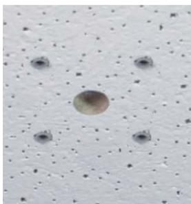
Fig. 14: Agujeros listos para el montaje
