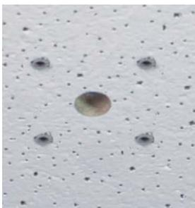
Fig. 16: Agujeros listos para el montaje
