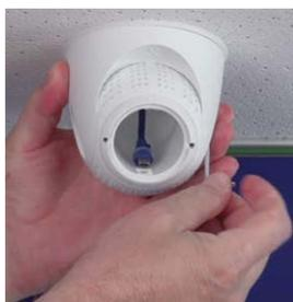
7. Allentare le due viti di fissaggio dell'inserto (1), quindi ruotare l'inserto in modo che la piccola barra opposta dell'etichetta **TOP/OBEN** sia rivolta verso il foro della vite di riferimento (2).
