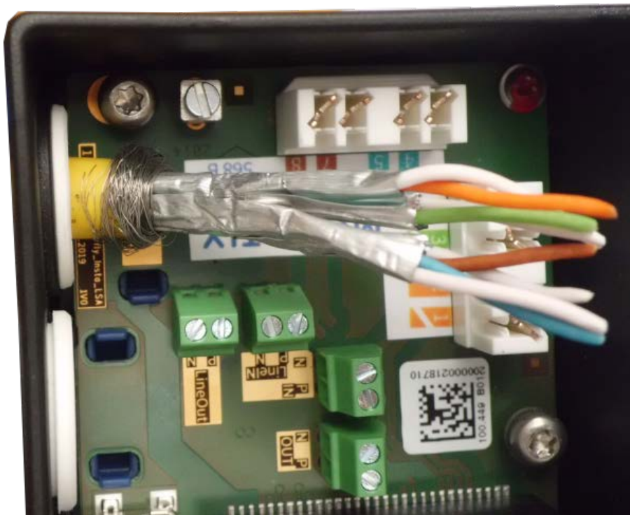
Fig. 60: Câble réseau inséré, bouchon correctement installé
