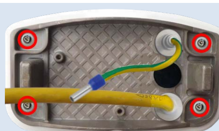
Fig. 37: Installé et prêt pour Boîtier de connexion LSA
