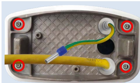
Fig. 51: Installé et prêt pour Boîtier de connexion LSA
