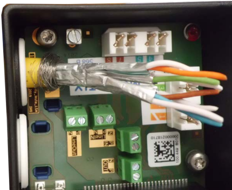
Fig. 60: Câble réseau inséré, bouchon correctement installé
