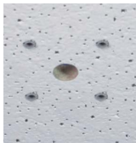
Abb. 14: Löcher bereit für Montage
