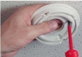
3. Lors du serrage des vis, veillez à toujours pouvoir tourner la bague rotative à la main.
