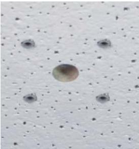
Fig. 16: Trous prêts pour le montage
