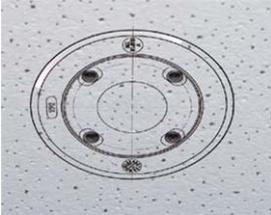
5. Au centre du gabarit de perçage, percez un autre trou dans le mur ou dans la plaque frontale pour le câble du module de capteur. Le diamètre du trou doit être compris entre 15 et 35 mm.
