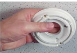
2. Fissare la piastra di base utilizzando le viti a legno e le rondelle fornite in dotazione.
