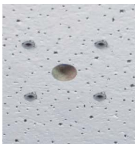
Fig. 16: Trous prêts pour le montage
