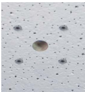
Fig. 14: Trous prêts pour le montage
