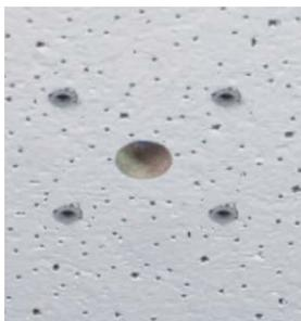
Fig. 14: Fori pronti per il montaggio
