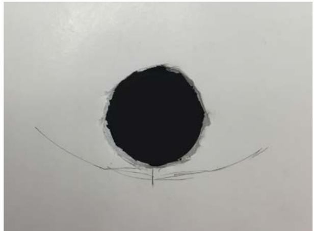
5. Percez un trou légèrement plus petit que la vis d'ancrage en plastique fournie sur chaque trou de vis marqué. Insérez ensuite les vis d'ancrage en plastique dans les trous percés.
