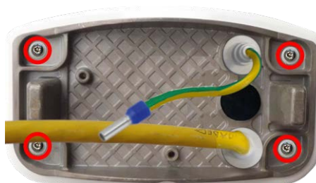
Abb. 37: Installiert und bereit für Connector Box LSA
