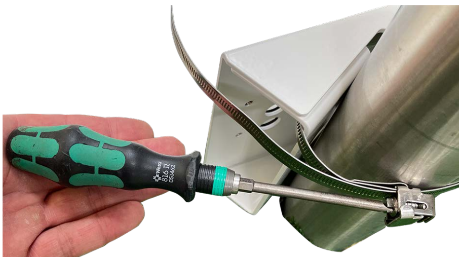
Fig. 42: Ajuste de las correas
