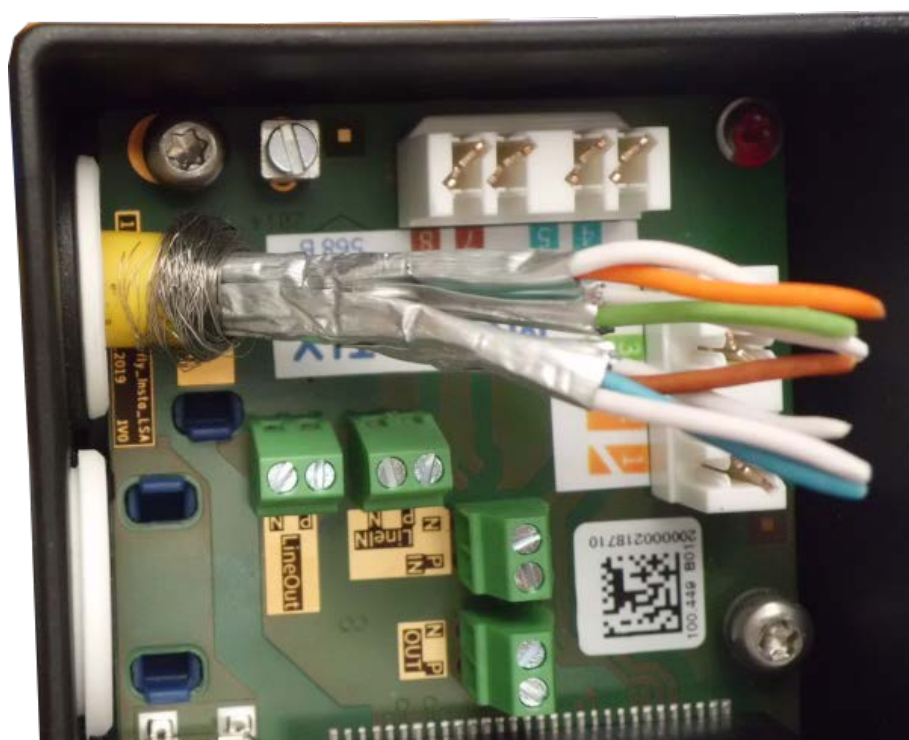
Fig. 56: Câble réseau inséré, bouchon correctement installé
