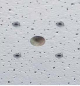
Fig. 14: Trous prêts pour le montage
