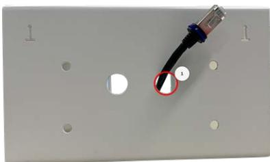
Fig. 11: Préparez le câblage réseau
