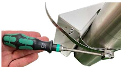
Fig. 13: Ajuste de las correas
