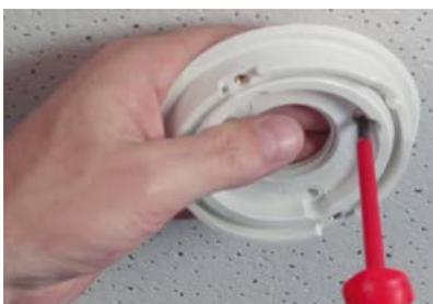
3. Durante il serraggio delle viti, assicurarsi di poter ruotare l'anello girevole manualmente.
