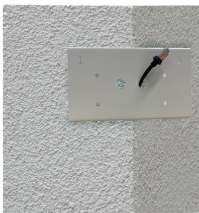
Fig. 12: Préparez le câblage réseau
