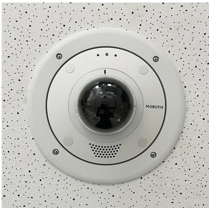
**ATTENZIONE!** Avant de monter la caméra, assurez-vous qu'une connexion réseau avec une alimentation conforme aux normes en vigueur PoE Plus (802.3at-2009) est disponible au niveau de la position de montage (voir [Connexion de la caméra au réseau](#)).
