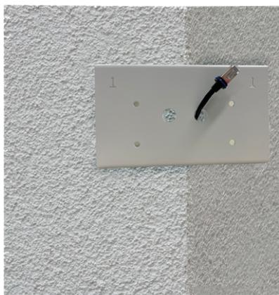
5. Procédez au montage du Wall Mount sur le Corner/Pole Mount comme décrit à la section [Montage avec le Wall Mount](#), p. 46.
