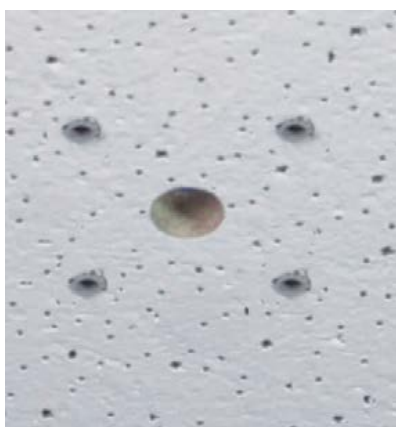
Abb. 16: Löcher bereit für Montage
