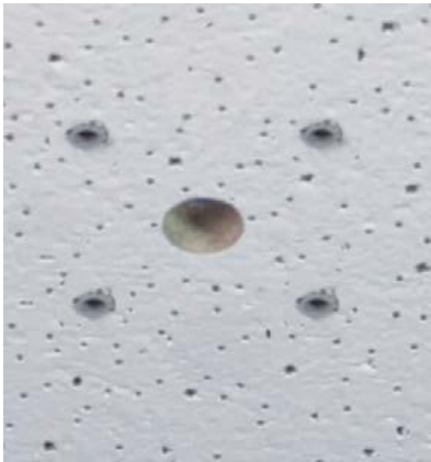
Abb. 14: Löcher bereit für Montage
