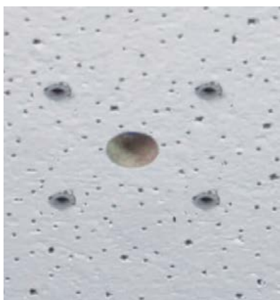
Fig. 16: Agujeros listos para el montaje
