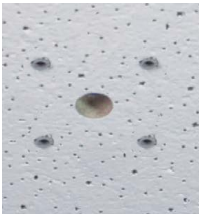
Fig. 16: Trous prêts pour le montage
