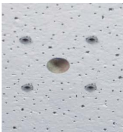
Fig. 16: Trous prêts pour le montage
