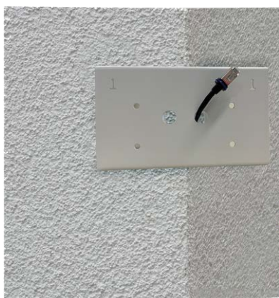
Fig. 12: Préparez le câblage réseau
