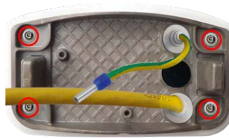
Abb. 38: Installiert und bereit für Connector Box LSA
