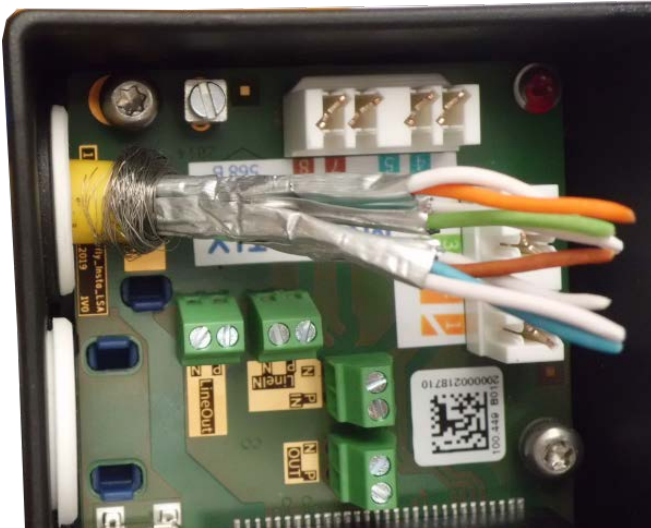
Abb. 57: Netzwerkkabel eingesteckt, Stopfen richtig eingesetzt
