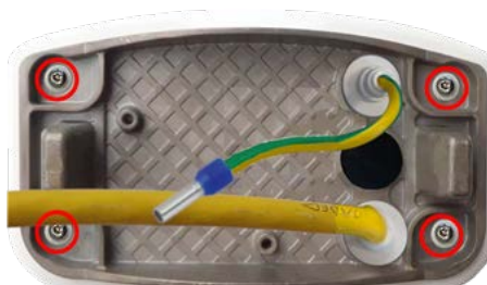
Abb. 51: Installiert und bereit für Connector Box LSA
