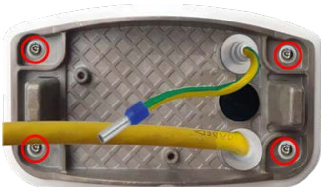
Abb. 55: Montageplatte mit Masseleitung und Netzwerkkabel
