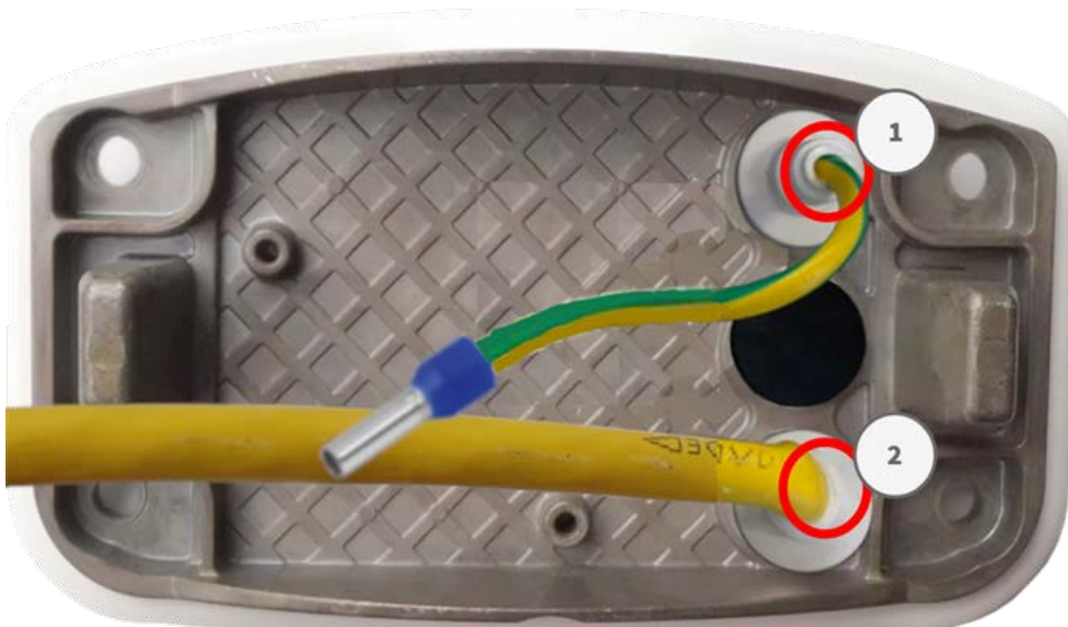
Abb. 49: Montageplatte mit Masseleitung und Netzkabel
