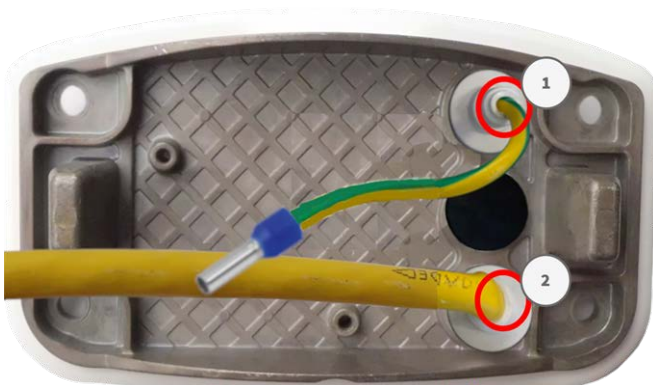
Abb. 36: Montageplatte mit Masseleitung und Netzkabel
