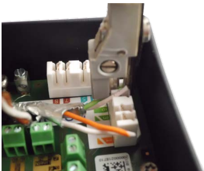
Fig. 60: Cables de red conectados mediante la herramienta LSA+/Krone
