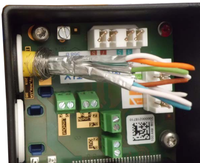
Fig. 57: El cable de red está introducido y el tapón, correctamente colocado
