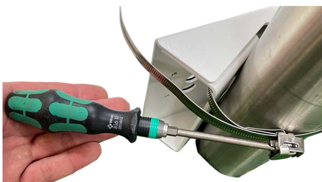
Fig. 43: Serrez les sangles
