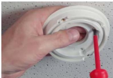
3. Achten Sie beim Anziehen der Schrauben darauf, dass der Schwenkring noch von Hand gedreht werden kann.
