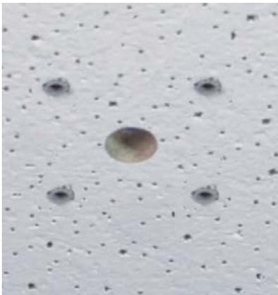
Abb. 15: Löcher bereit für Montage
