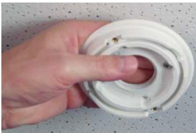
2. Befestigen Sie die Grundplatte mit den mitgelieferten Holzschrauben und Unterlegscheiben.
