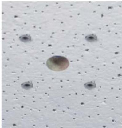
Abb. 13: Löcher bereit für Montage
