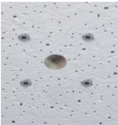
Fig. 13: Fori pronti per il montaggio
