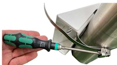
**Fig. 14: Ajuste de las correas**
