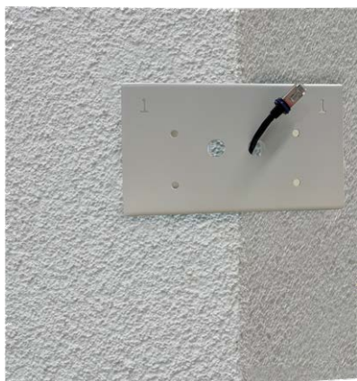
Fig. 12: Préparez le câblage réseau
