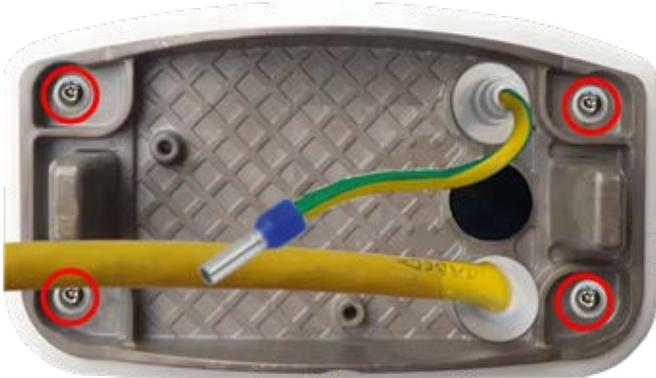
Abb. 28: Montageplatte mit Masseleitung und Netzkabel
