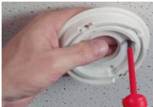
7. Far passare il cavo del sensore attraverso l'anello girevole e la piastra di base.
