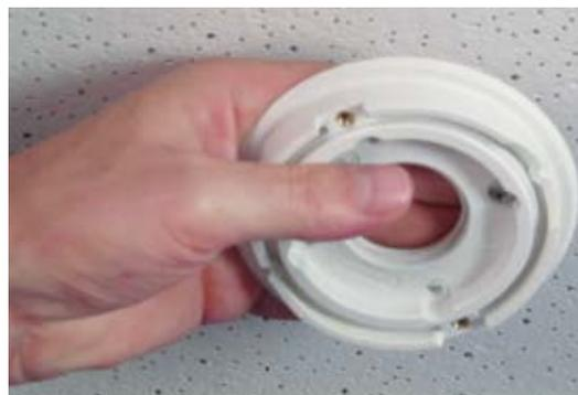
7. Fissare la piastra di base utilizzando le viti a legno e le rondelle fornite in dotazione.
