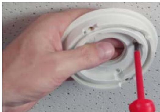
8. Durante il serraggio delle viti, assicurarsi di poter ruotare l'anello girevole manualmente.
