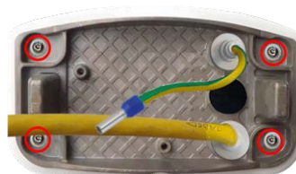
Fig. 18: Instalado y listo para Caja de conexiones LSA
