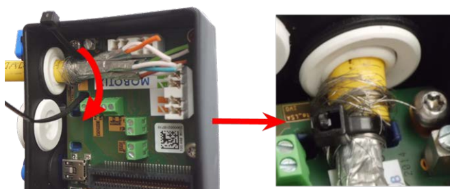
Fig. 25 : Attache de câble insérée sous le câble de réseau
