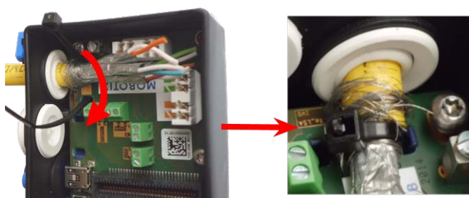
Fig. 25: Fascetta inserita sotto il cavo di rete
